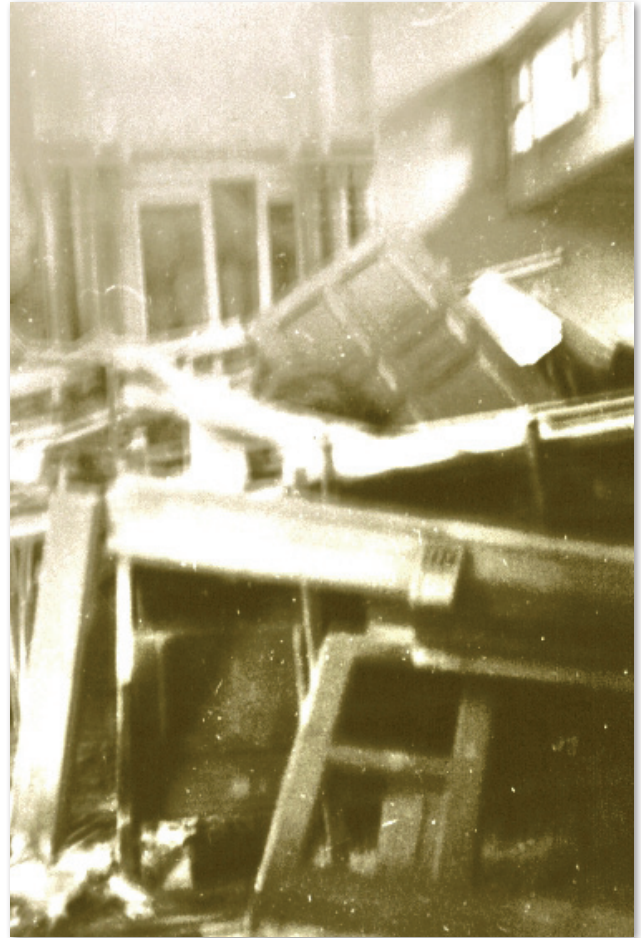
Zerstörte Synagoge, 10.11.1938, Aufnahme innen
