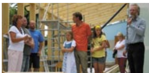
28.08.09 Richtfest des Neuanbaus
